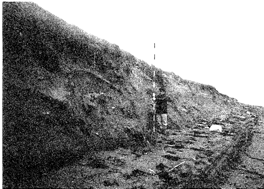
新潟県新川漁港周辺の侵食状況（地点B）
